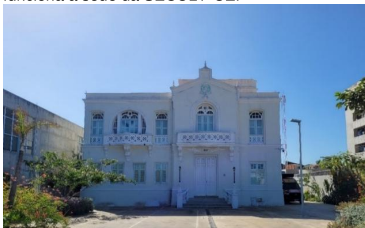
Figura 14. Vista da antiga Casa do Engenheiro da Estação, onde atualmente funciona a sede da SECULT-CE.
