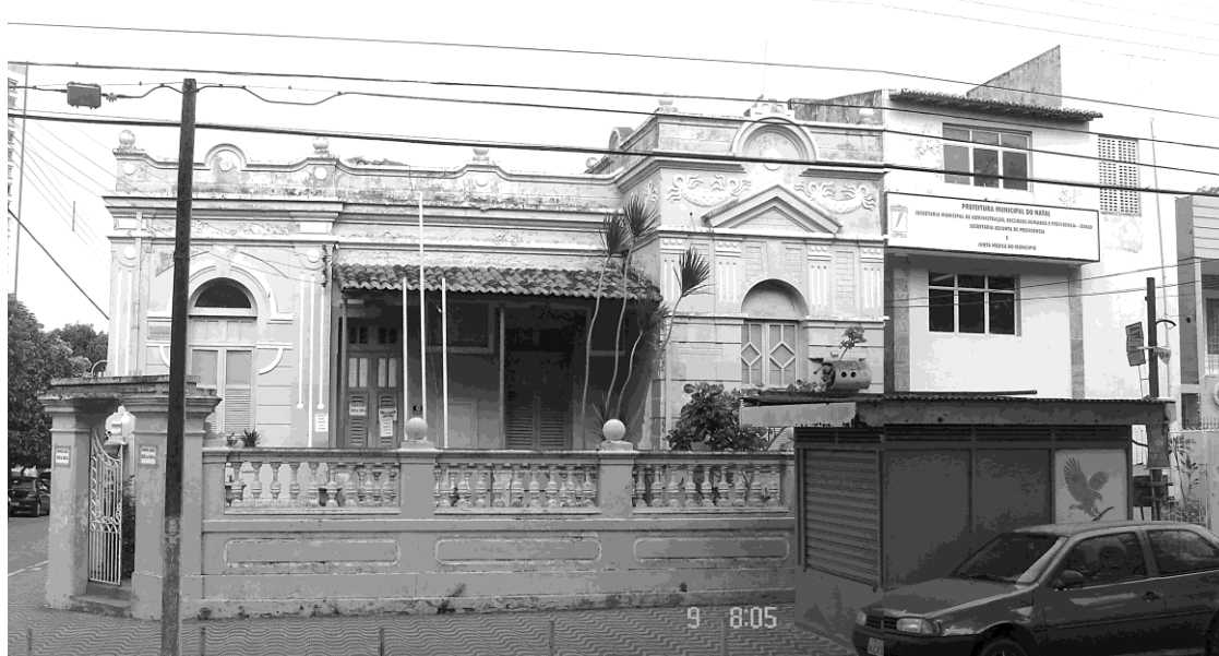
Figura 5. O edifício da sede do IPREVINAT: registro da volumetria original de estética eclética e o subsequente anexo de linguagem modernista (1980).
