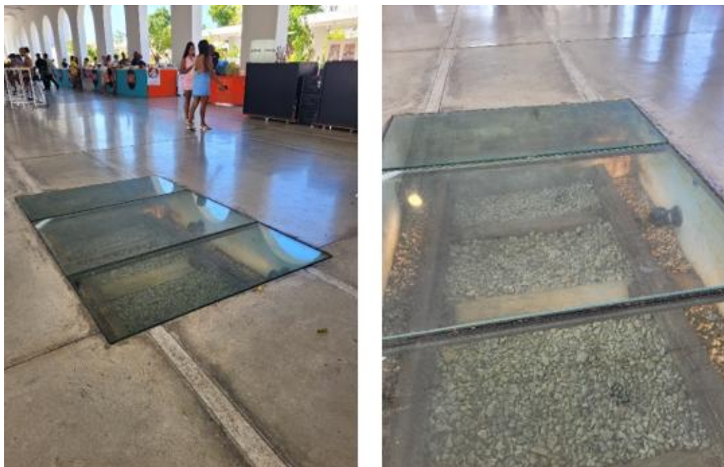
Figura 15. Janela de visualização dos trilhos pré-existentes na antiga gare.
