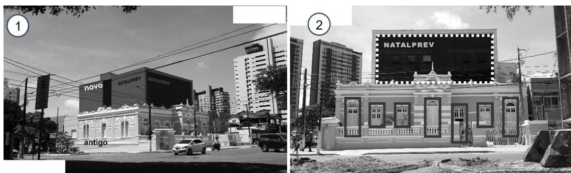
Figura 13. Ampliação externa: relação entre o novo e o antigo (imagem 1) Fenestrações do edifício novo e do prédio antigo em ritmos diferentes (imagem 2)
