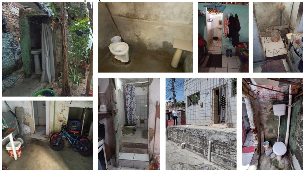
Figura 4. Imagens dos ambientes escolhidos por seus moradores para as obras de melhoria e adequação à acessibilidade.
