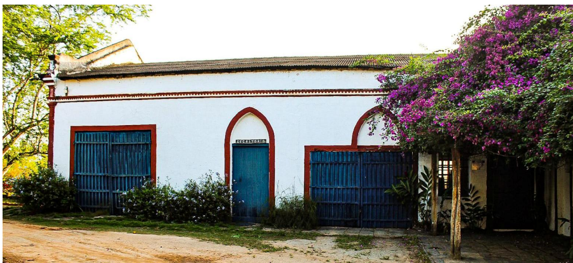
Figura 5. Situação da fachada principal da casa-sede.
