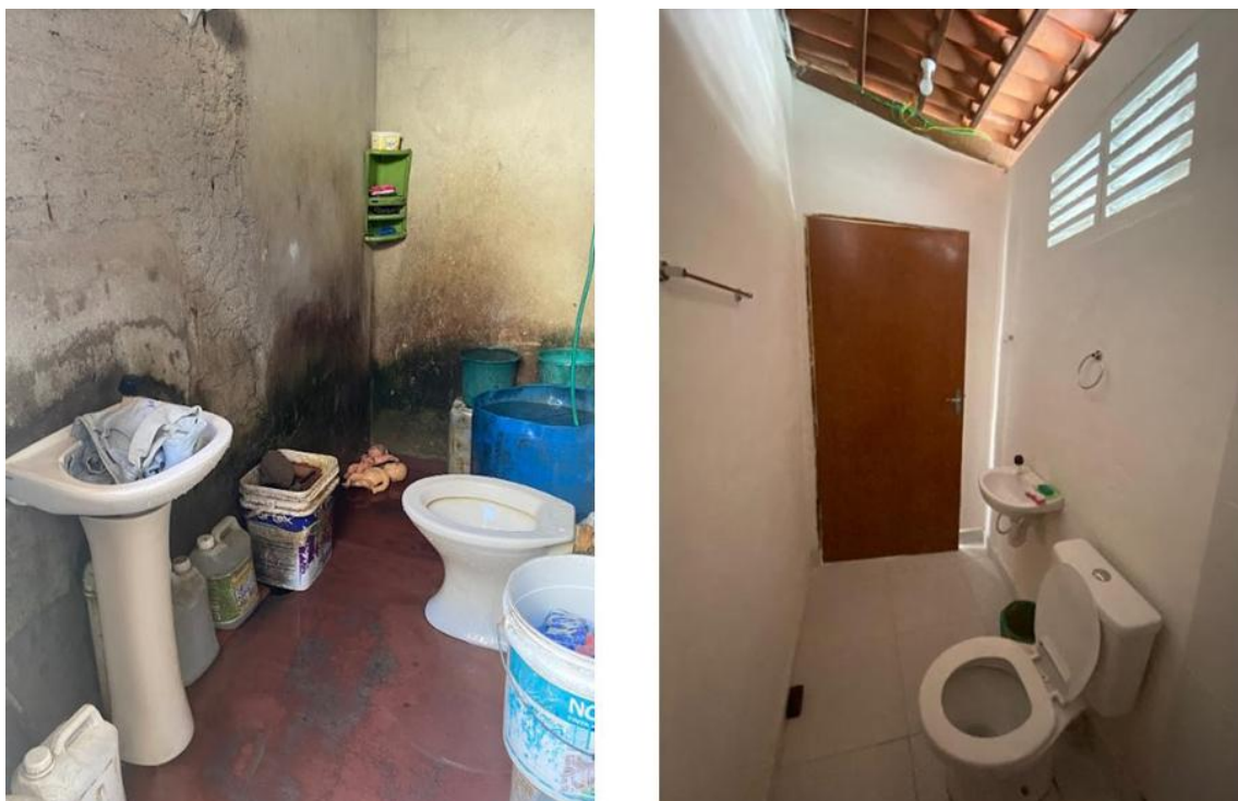
Figura 8. Antes (à esquerda) e depois (à direita) da reforma da cozinha
