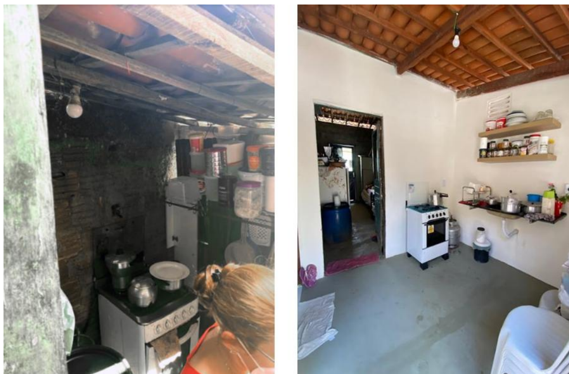
Figura 7. Antes (à esquerda) e depois (à direita) da reforma da cozinha
