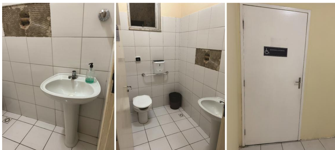
Figura 10. Banheiro acessível do primeiro pavimento
