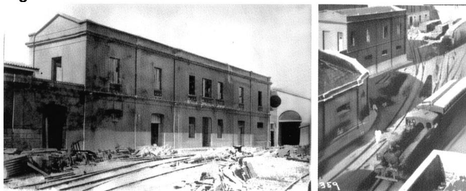
Figura 6. Novo edifício administrativo construído em 1922.
