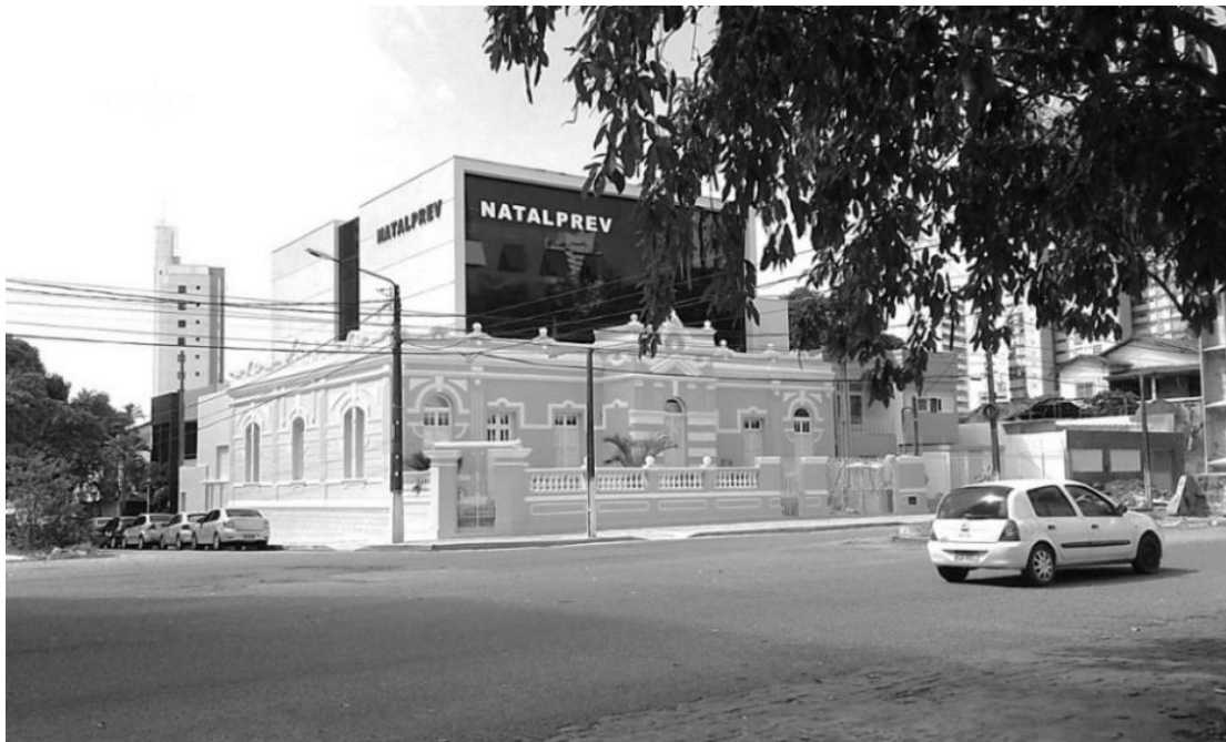
Figura 3. Edifício da atual sede da Natalprev: relação entre a preexistência e a ampliação
