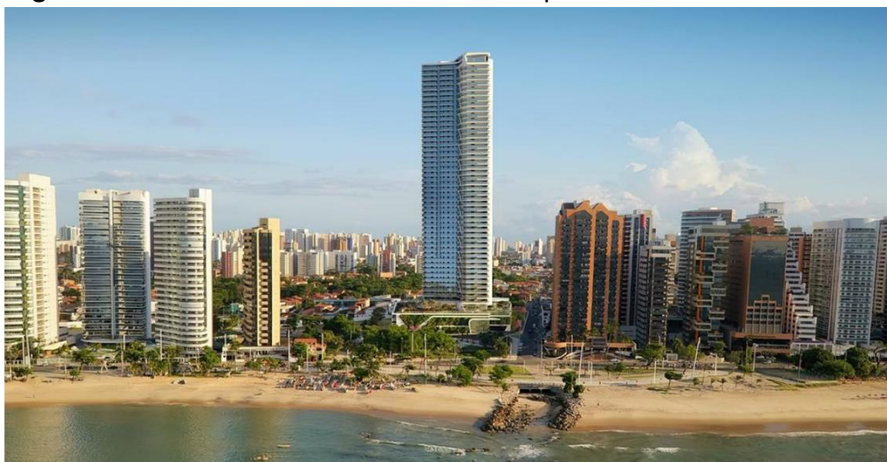
Figura 1. Edifício One Residencial, Mucuripe, Fortaleza-CE.
